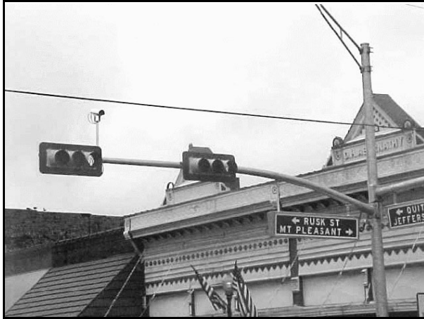
a. Mast Arm Camera Mount.
